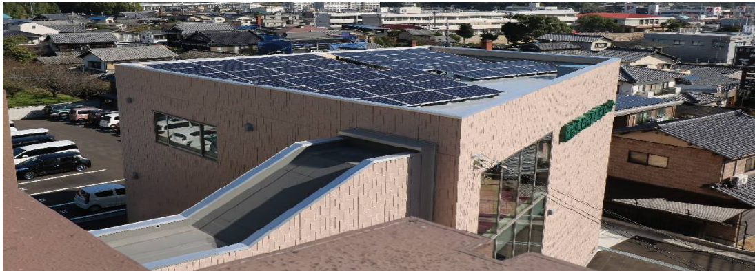
(写真)事務センター 太陽光発電システム
